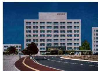
図-3 既存病院建物
