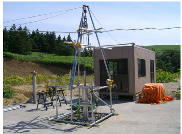
写真-2 孔内原位置測定試験状況
