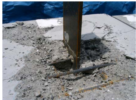
写真-2 破壊後の状況 (C3-2)
