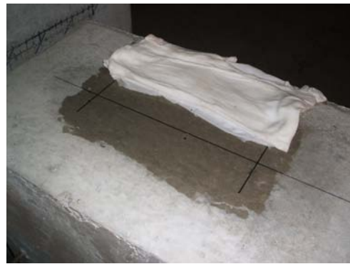
写真-4 湿布によるコンクリート面の給水状況
