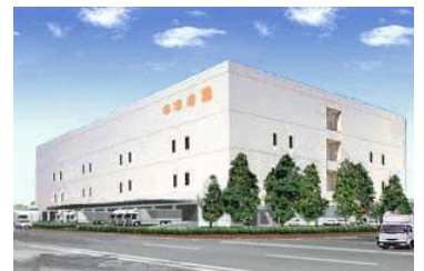
図-4 新築物流倉庫
