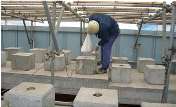
写真-2 自由振動測定状況
