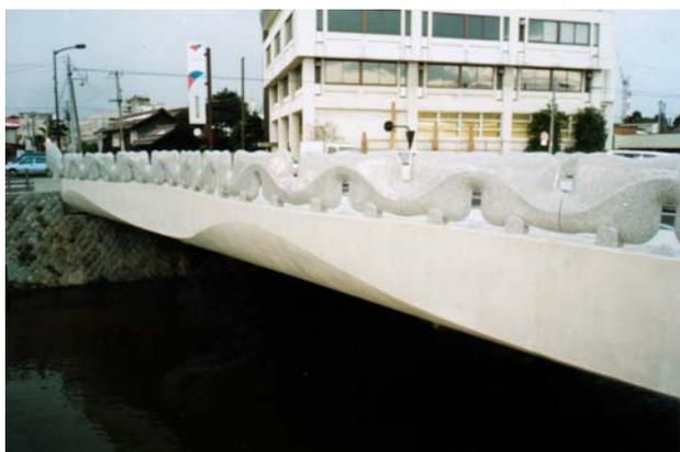
写真-1 RC 張出し床版への適用
