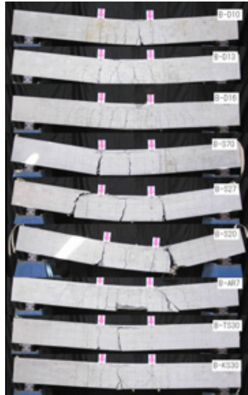
写真-2 曲げ試験体ひび割れ形状
