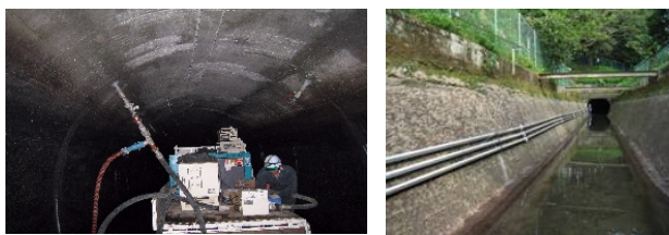
充填作業場状況と坑口近傍配管
