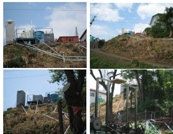
急傾斜部配管状況
