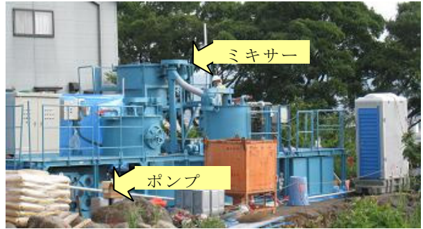
写真-3 ミキサー, およびポンプ設置状況
