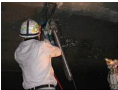
(a) 注入口削孔作業状況
