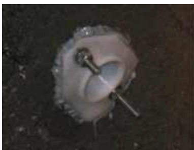
(b) 注入口設置状況
