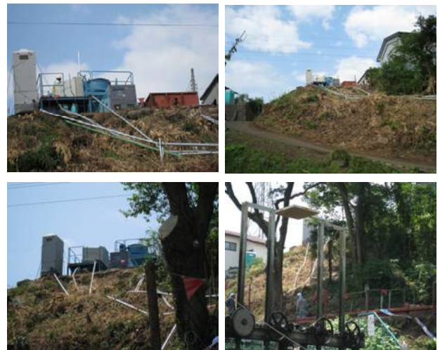
写真-8 混練りプラントおよび法面部配管状況
