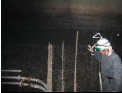
写真-10 貫通割れ目からの漏出状況
