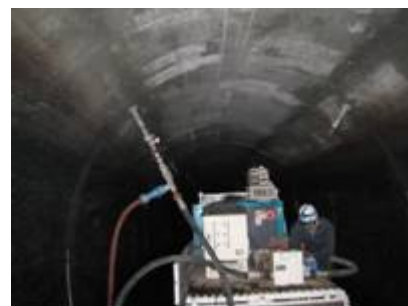
写真-7 充填作業状況
