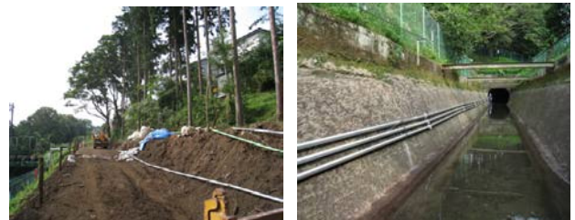
(a) 水平配管部 (b) 開水路配管部
