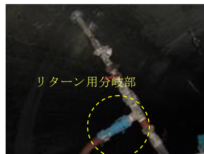
写真-6 注入管先端部のリターン用分岐
