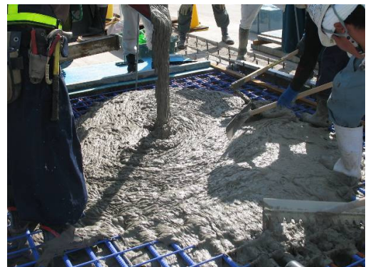
写真-6 実際の工事における打込みの状況
