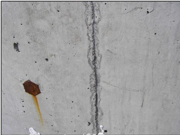
写真-3 計測対象の段差 (1 mm)
