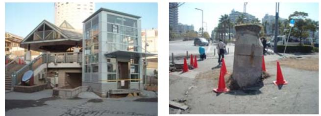
液状化による地盤沈下 マンホールの浮上り
