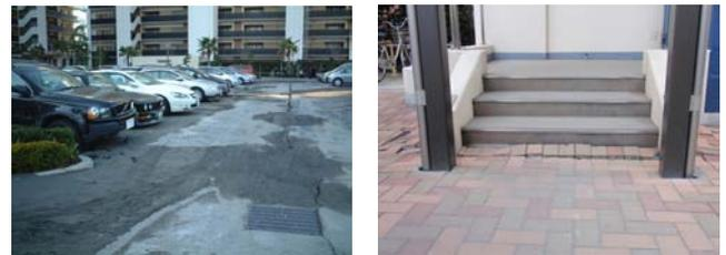
駐車場での噴砂と亀裂 改良・未改良範囲の境界での地盤沈下
