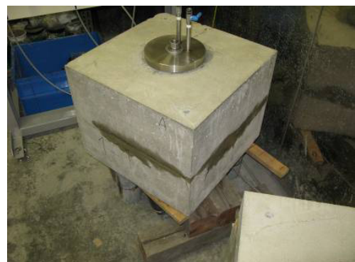
写真-1 漏水状況
