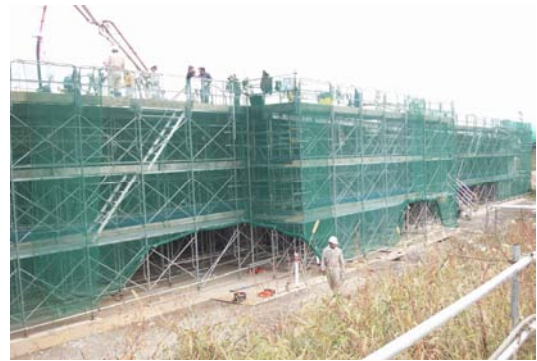
図-5 コンクリート打設状況
