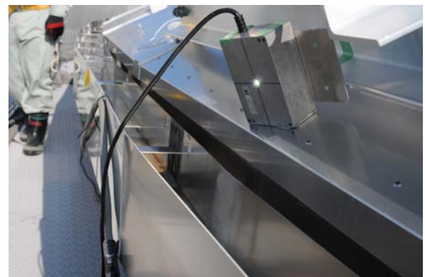
図-10 屋根端部へのLED光源設置状況
