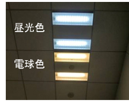
写真-3 二種類の蛍光灯
