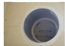
蓄熱エレメント設置
