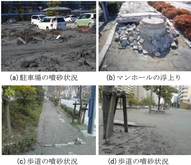
写真-1 液状化被害状況（新浦安）
