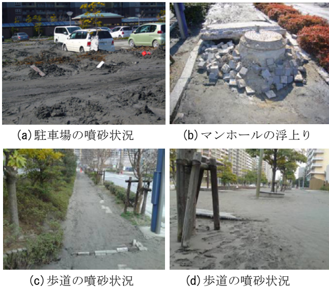
写真-1 液状化被害状況（新浦安）
