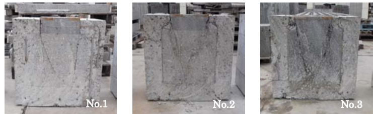
写真-1 試験体切断面
