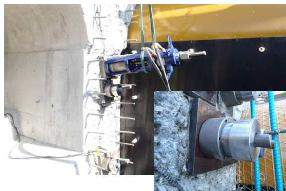
写真-5 PC 鋼棒の定着具設置状況
