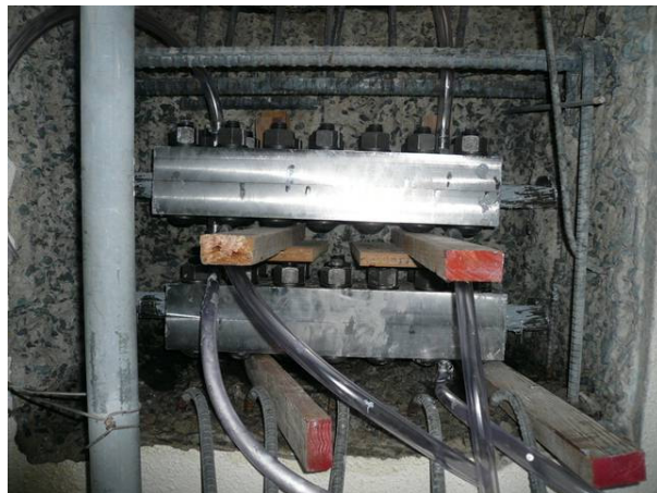
(2)中間定着体の設置
