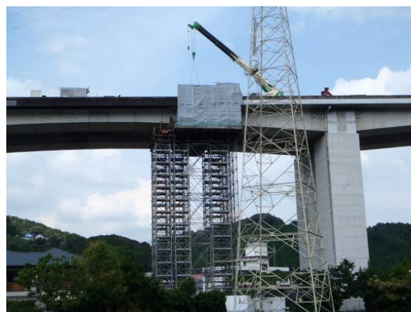
写真-4 ゲルバーヒンジ撤去工事状況
