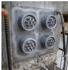
写真-2 膨張材を用いた中間定着工法による PC 大梁の解体
