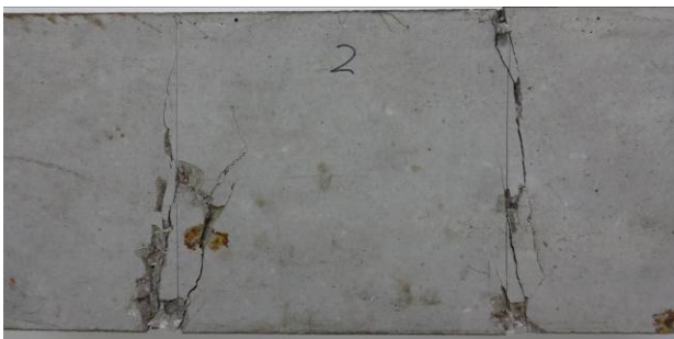
写真-3 ひび割れを発生させた供試体
