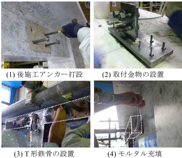
写真-1 T形鉄骨の施工状況
