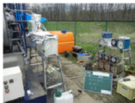
図-5 排ガス等サンプリング状況
