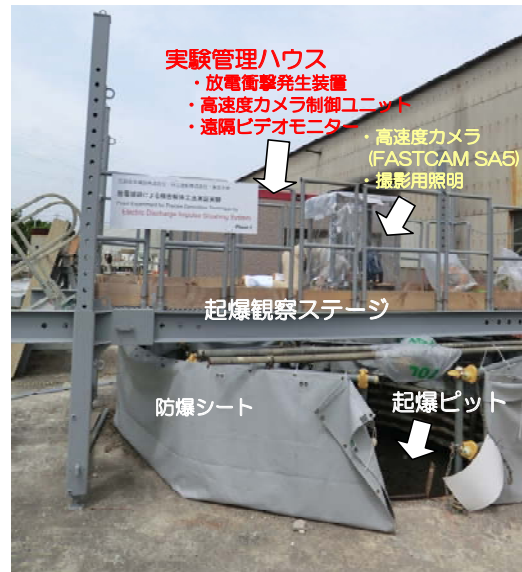
写真-2 起爆設備・実験管理設備外観
