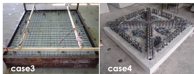
写真-1 補強状況
