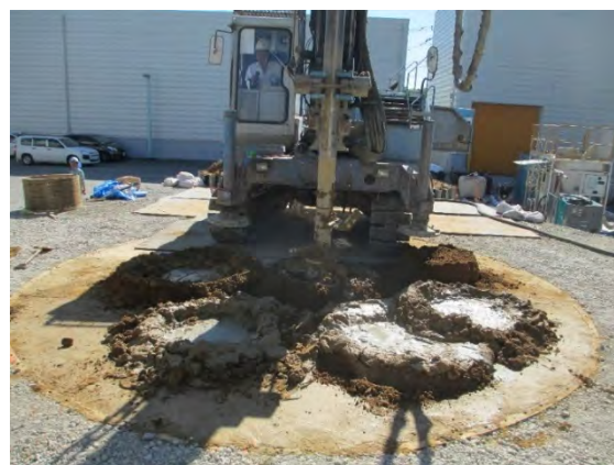
写真-1 改良杭施工状況
