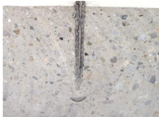
写真-4 引抜き試験 突起部状況
