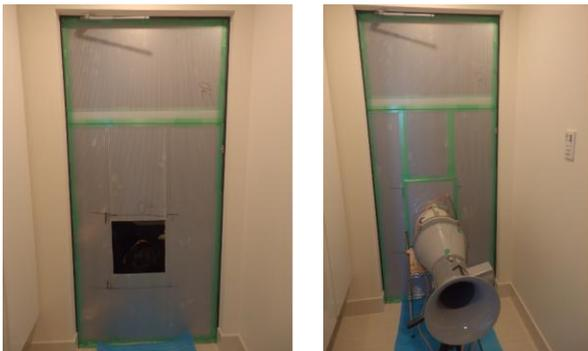
プラスチックダンボールを設置(仮固定)し、確認した高さに気密測定装置を通す穴を開ける。
