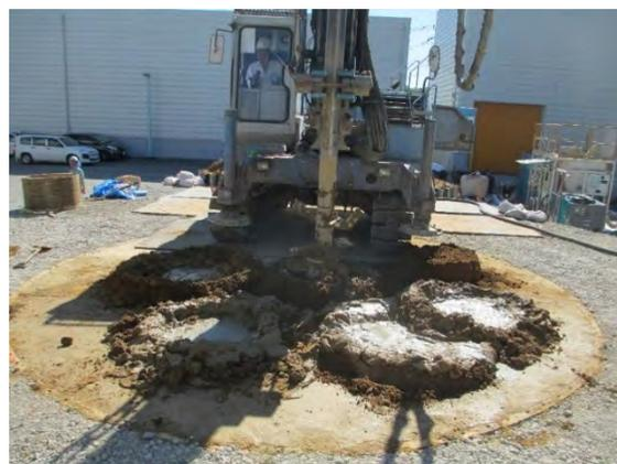
写真-1 改良杭施工状況
