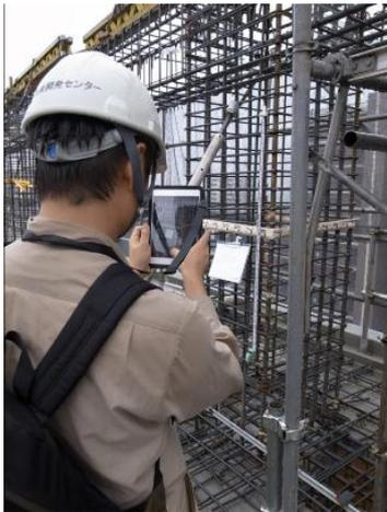
写真-1 配筋検査状況
