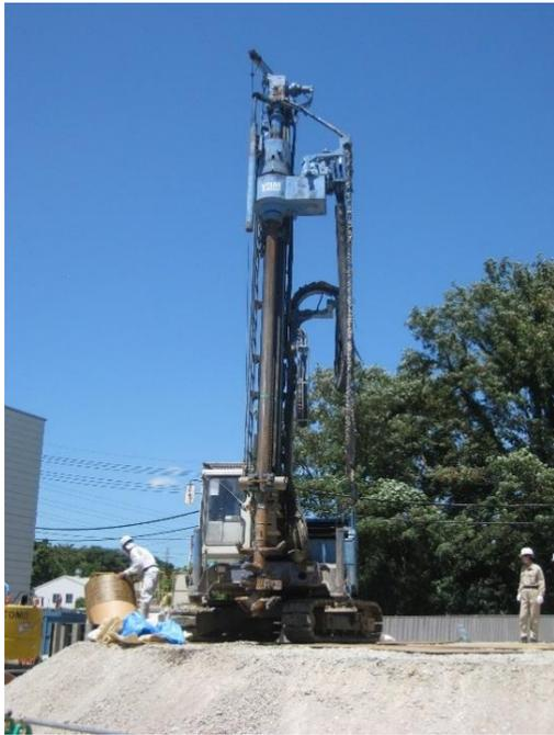
図-8 深層混合処理機
