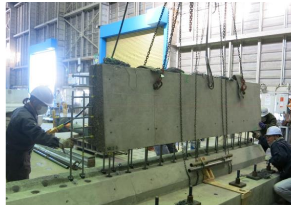
写真-4 実物大試験体の施工性確認試験
