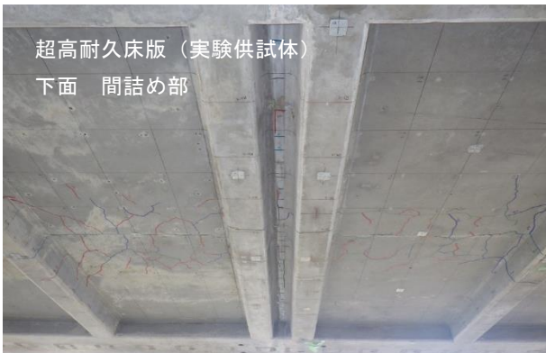
写真-3 水漏れなし (輪荷重走行試験後)
