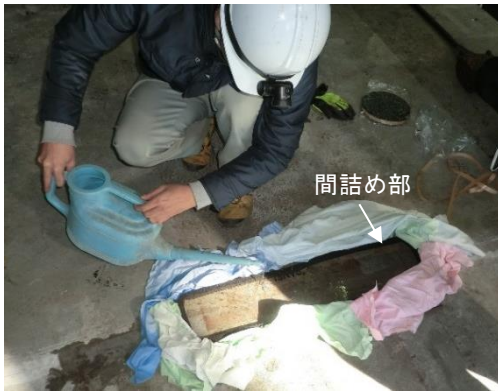
写真-2 超高耐久床版の水張り試験
