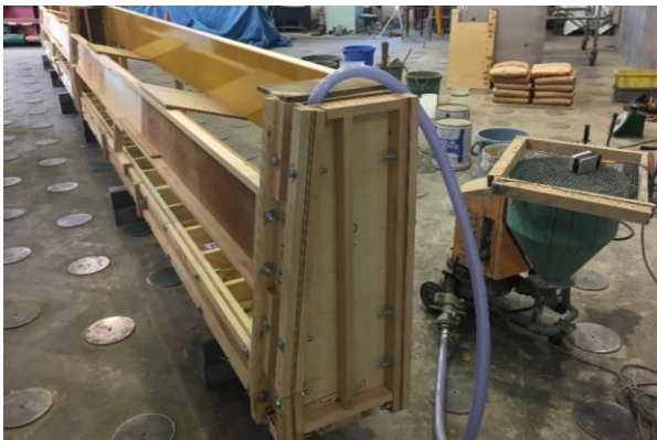
写真-1 無収縮モルタルの充填状況
