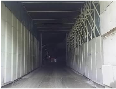
写真-2 吸音装置設置状況
