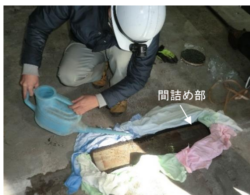
写真-2 超高耐久床版の水張り試験
