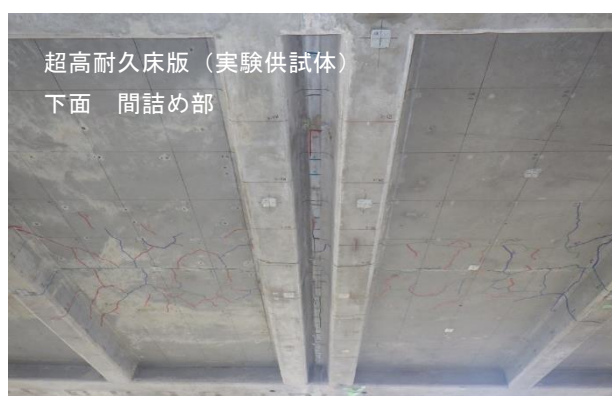
写真-3 水漏れなし（輪荷重走行試験後）
