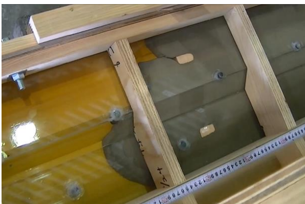
写真-2 壁高欄基部のモルタル充填状況
