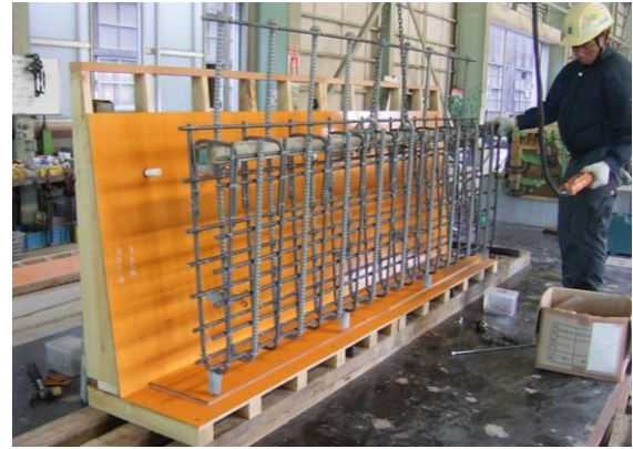
写真-3 壁高欄のプレファブ鉄筋組立
