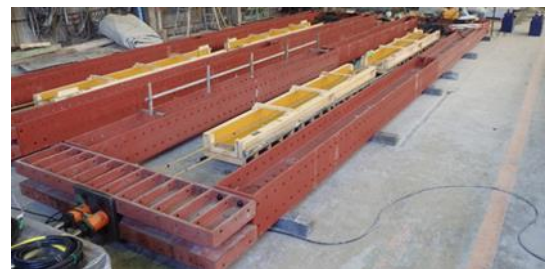
写真-1 試験体製作状況
