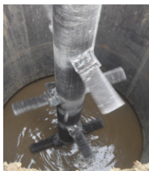
写真-1 ロッドに取付けた攪拌翼
