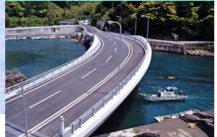
久礼橋は、県道久礼須崎線に位置する旧橋の老朽化に伴い架け替え架設中の2径間連続T形ラーメン箱桁橋です。
