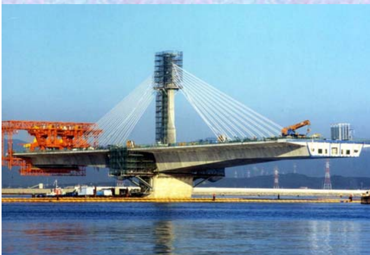
P2張出し架設終了
