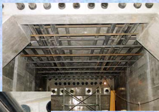
ケーブル配置状況
