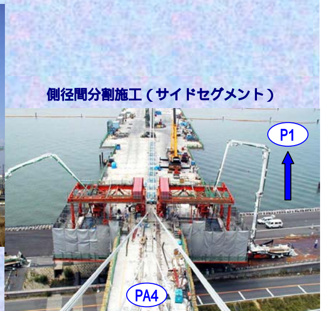
側径間の逆張り出し施工(コアセグメント)
