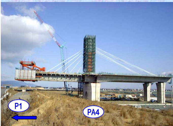
側径間の逆張り出し施工(コアセグメント)
