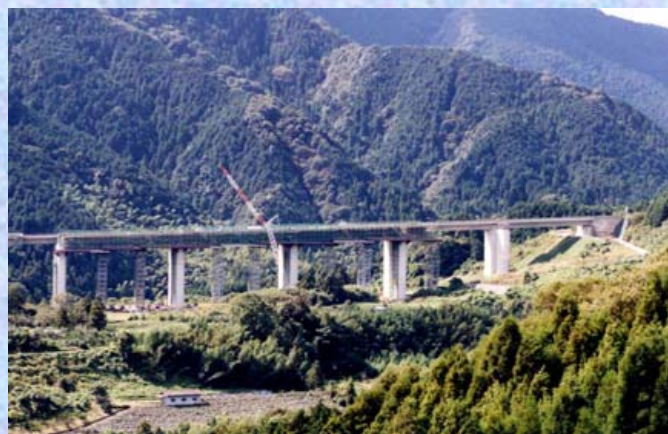
手前側 期線工事 A1～P5（右側 A1）
