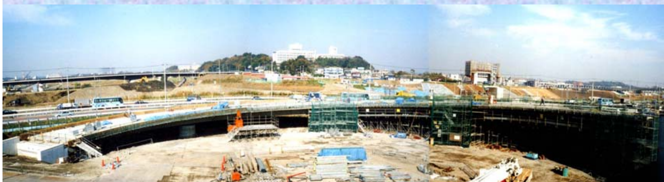
支保工架設全景
