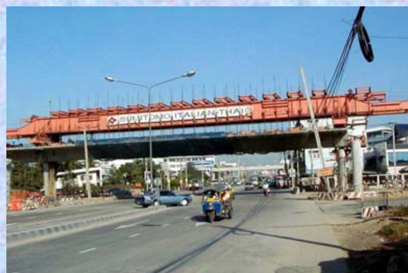
高架橋 プレキャストゲメント架設
