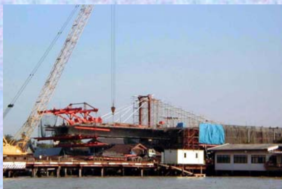
主橋側径間部逆張出し架設
