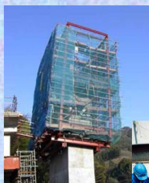
クライミング 施工
