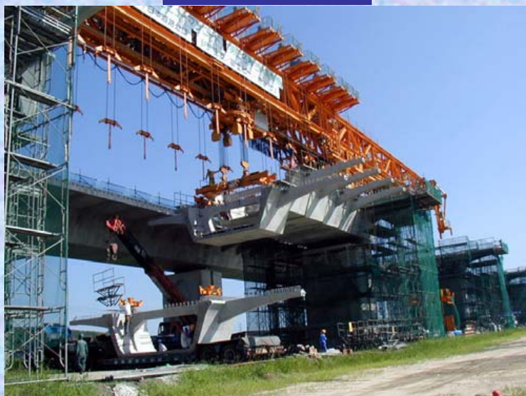
セグメントの架設
