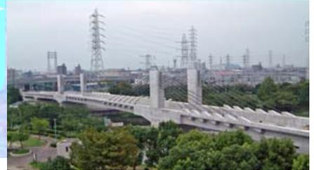
荒子川橋りょうは、名古屋臨海高速鉄道西名古屋港線のうち、荒子川を斜めに横切る橋長 245.9m の PC 4 径間連続エクストラード下路桁橋です。
