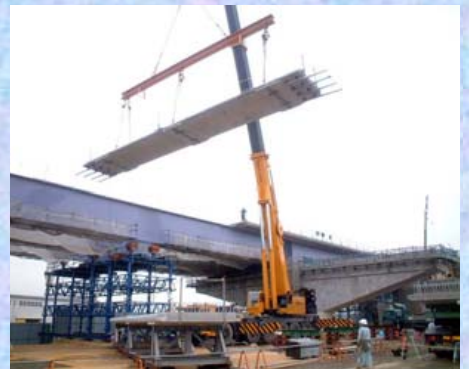
PC床版架設
