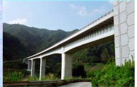
津久見川橋は、東九州自動車道の津久見ICと佐伯IC間に架橋される橋長291.0mの5径間連続波形鋼板ウエブラーメン箱桁橋です。
