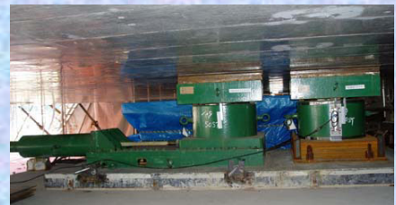
ARC工法押し出し装置（主桁部）
