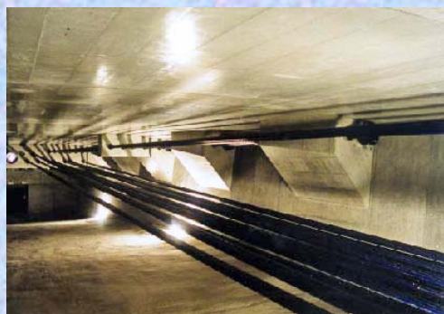
外ケーブル配置状況
