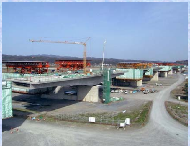
張出し架設状況
