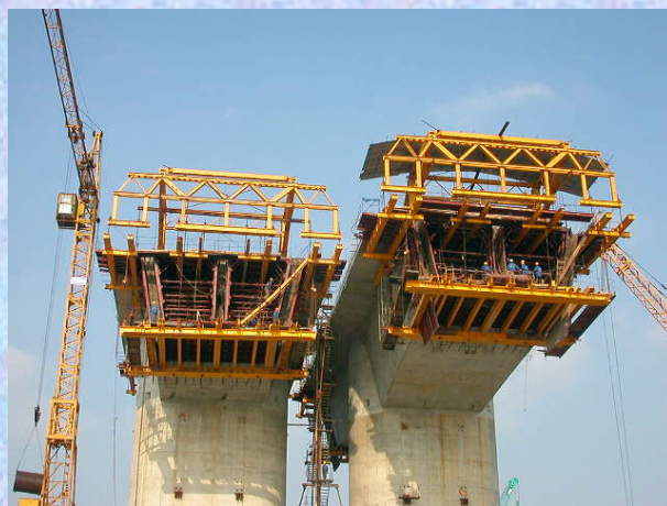
張出し架設 (主橋)
