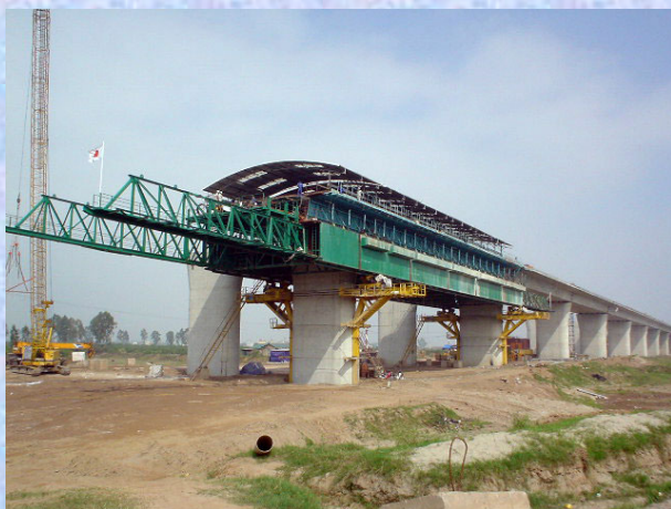
移動支保工 (アプローチ橋)
