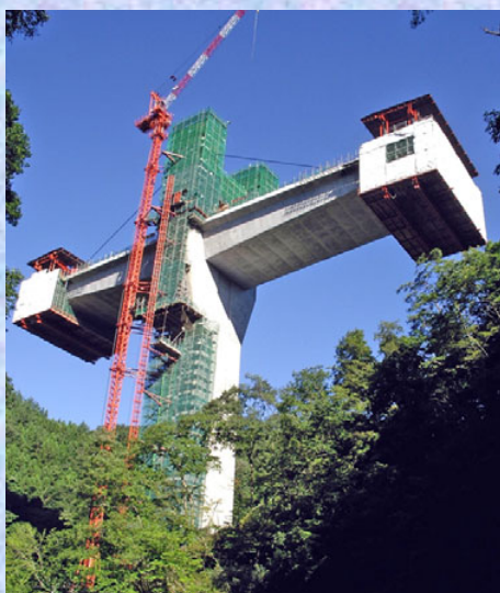
張出し架設状況
