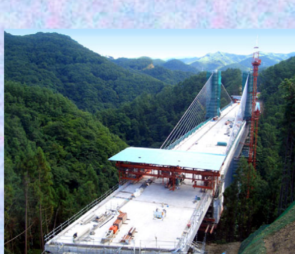
橋体工完成状況
