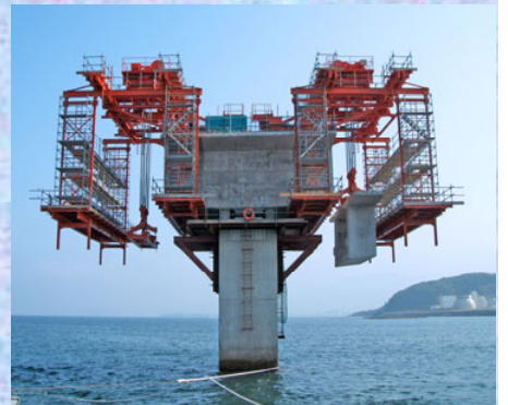
主桁セグメント架設状況
