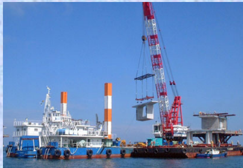
基準セグメント架設状況
