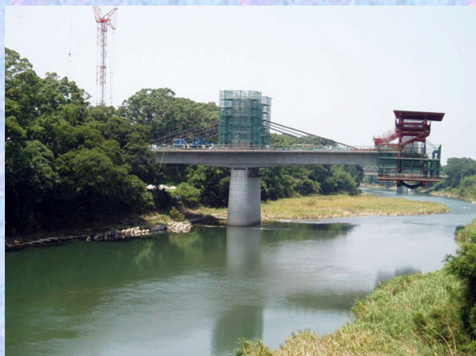
P1 側張出し架設状況
