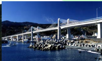
(エクストラドーズド橋、支間 122m)
