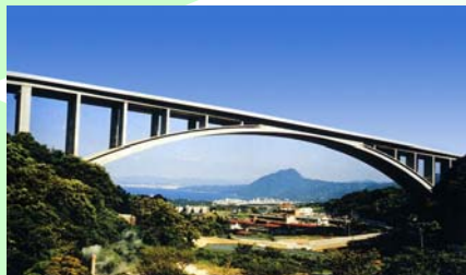
(アーチ橋、支間 235m)
