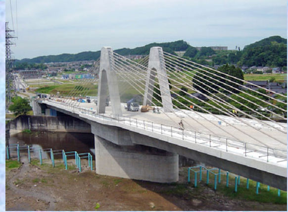
2次施工区間完了後
