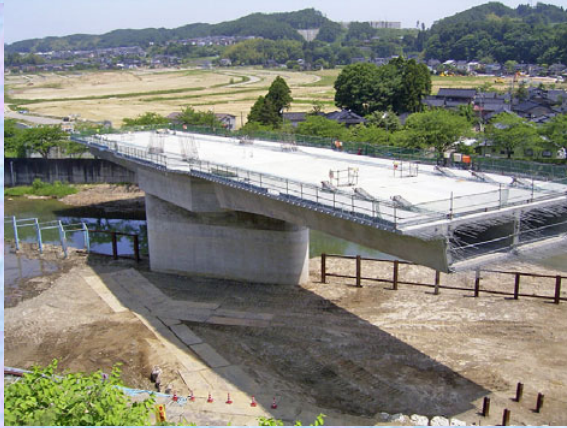
1次施工区間完了後
