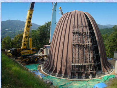
セグメント架設
