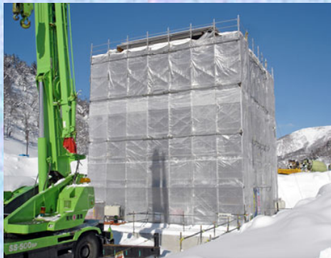
橋脚冬季養生
