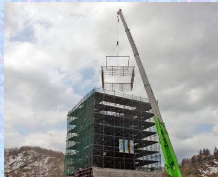
橋脚部プレファブ鉄筋吊り込み
